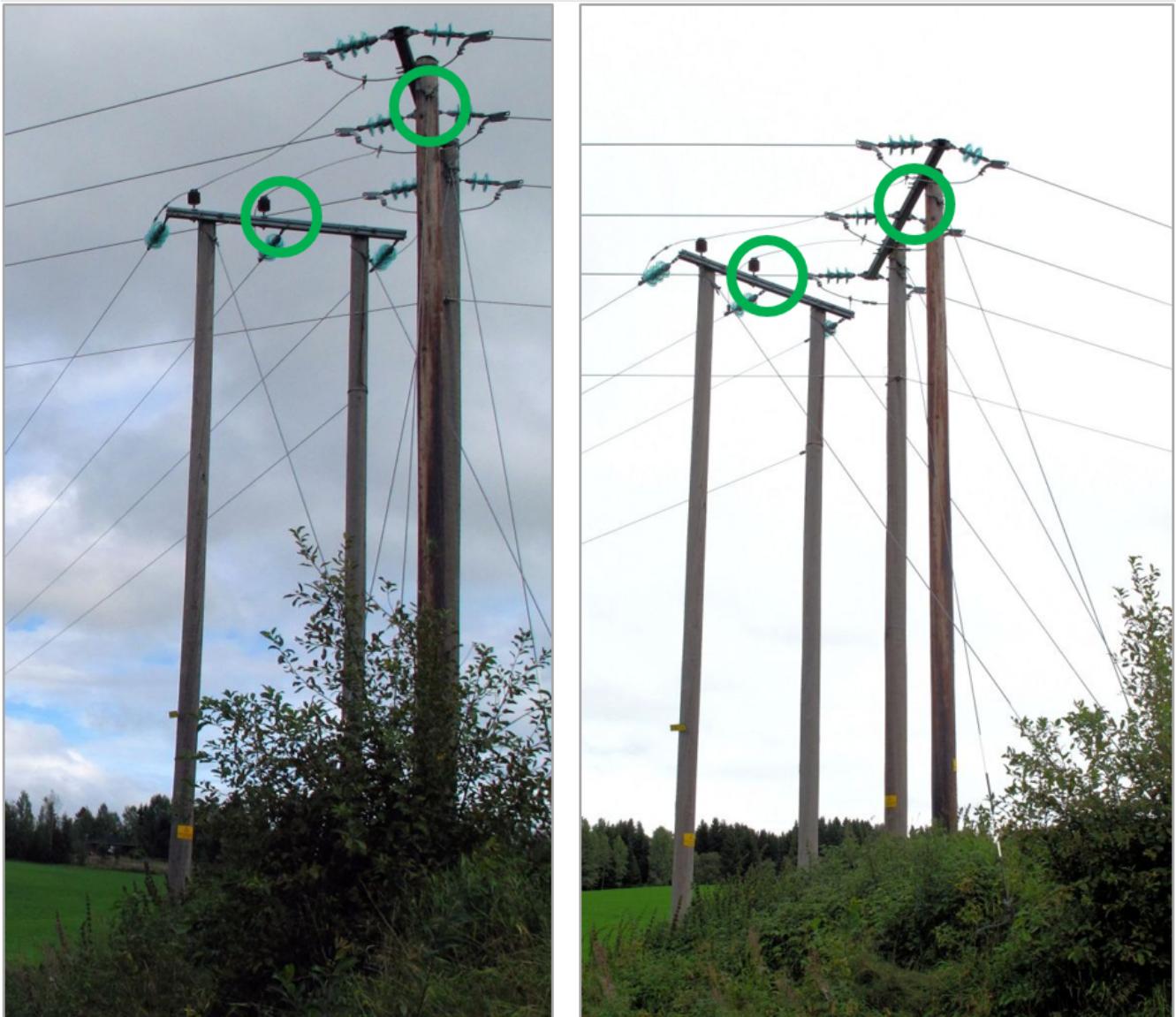
Figur 56. Traseknutepunkt som skal registreres som to master (mastepunkt = grønn ring)
