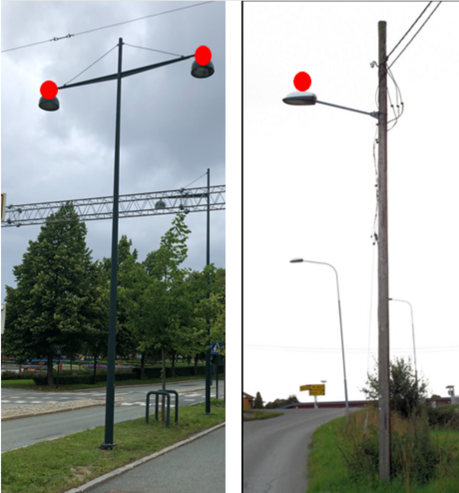
Figur 18. Eksempel på registrering av lysarmatur i mast. Kun et utvalg armatur er markert med rød prikk. Dette er ikke en påkrevet registrering ved fotogrammetri.
