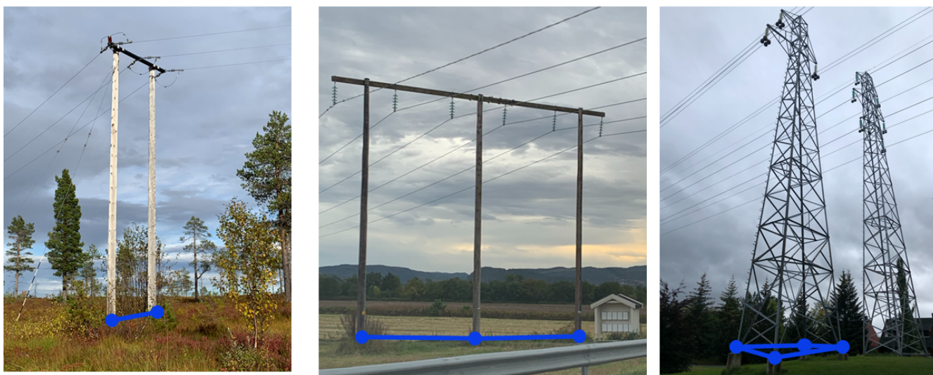
Figur 27. Eksempel på registrering av Masteomriss for StolpeStor og Fagverksmast. Hvert enkelt punkt i kurven angir det enkelte fundament for masten.
