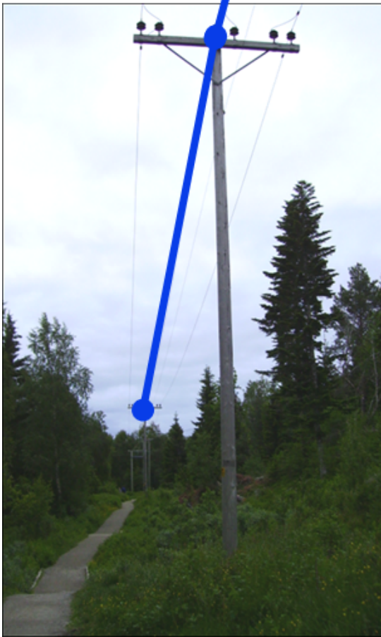
Figur 39. Eksempel på registrering av høgspentlinje
