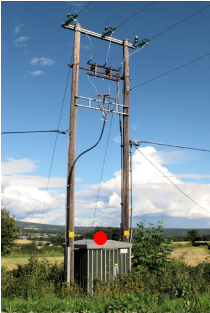
Figur 31. Eksempel på registrering av mastefotkiosk som representasjonspunkt.
