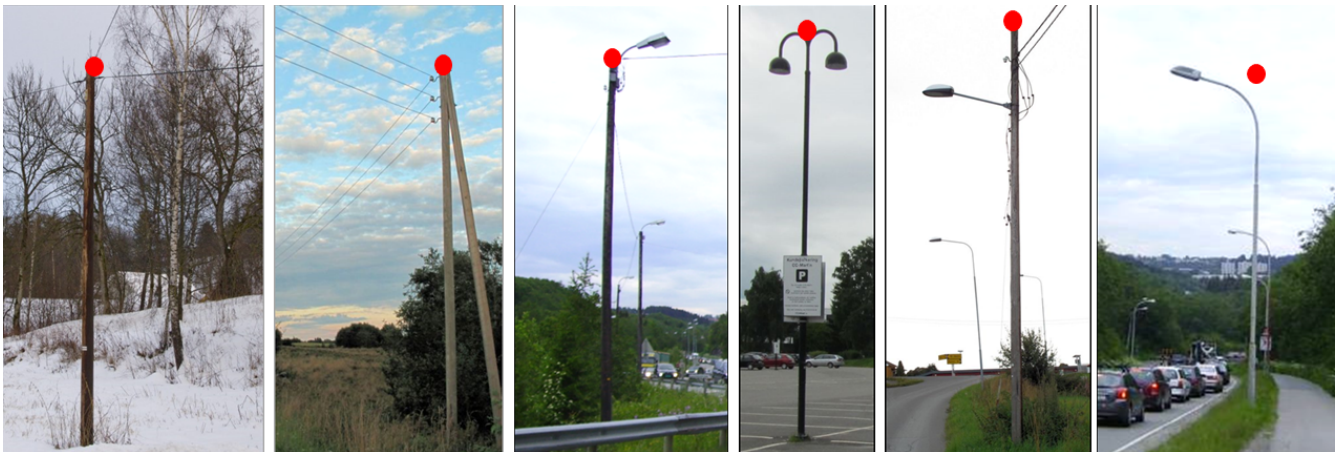
Figur 22. For enkeltstolper skal topp mast registreres. I noen tilfeller, typisk på veilyst, må man generere topp mast (se figur lengst til høyre)
