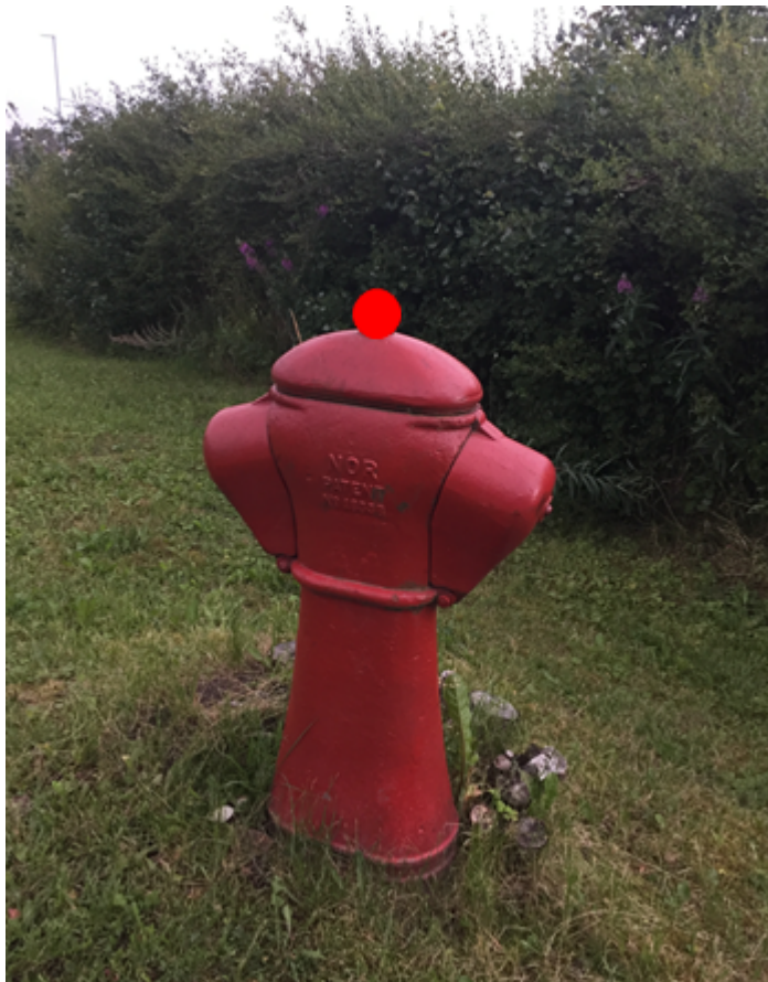
Figur 10. Senter topp hydrant skal registreres
