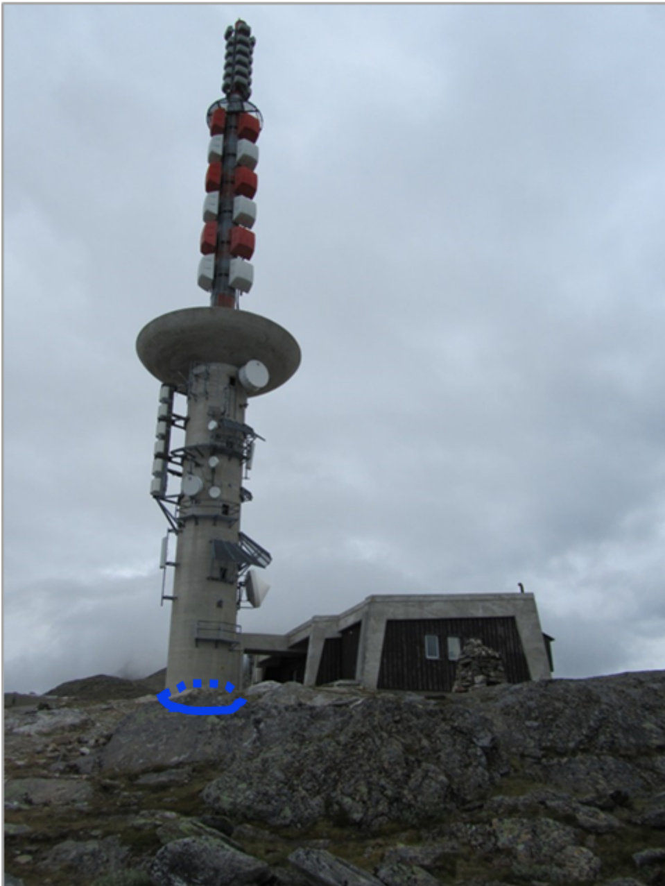
Figur 28. For mast som har betongfundament, typisk rund form, registreres omriss av fundamentet.
