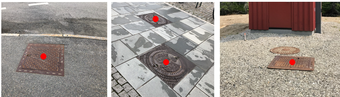
Figur 11. Senter kumlokk skal registreres. I bildet til venstre vises både et kvadratisk og sirkelformet kumlokk
