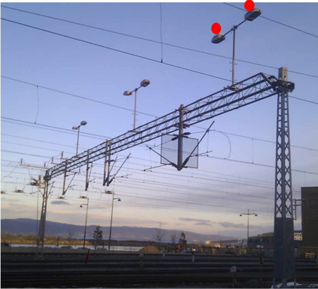
Figur 17. Eksempel på registrering av lysarmatur i/på åk. Kun et utvalg armatur er markert med rød prikk. Dette er ikke en påkrevet registrering ved fotogrammetri.
