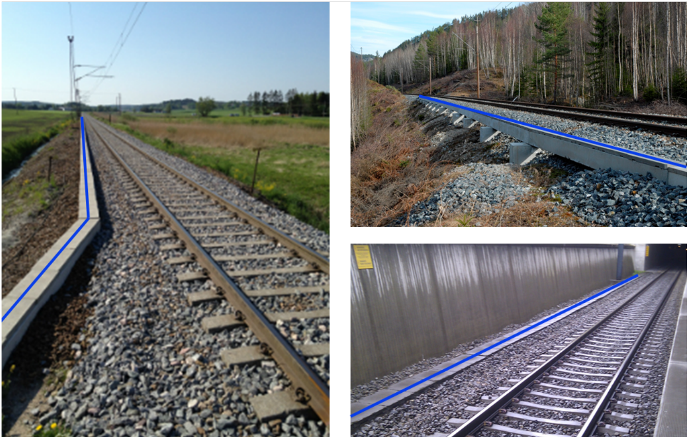
Figur 6. Registrering av kabelkanal (foto: Bane NOR)
