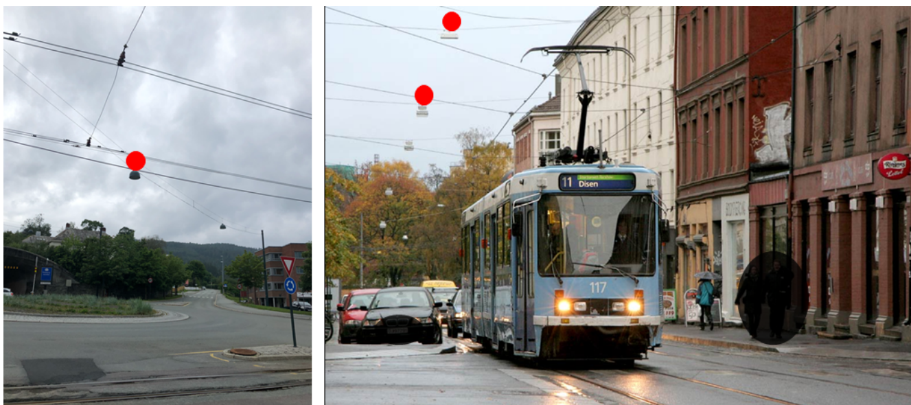
Figur 16. Topp senter lysarmatur for lysarmatur i vaier over gater/veger skal registreres
