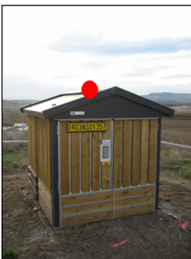
Figur 32. Eksempel på registrering av minikiosk som representasjonspunkt.
