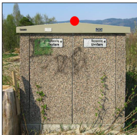
Figur 32. Eksempel på registrering av minikiosk som representasjonspunkt.
